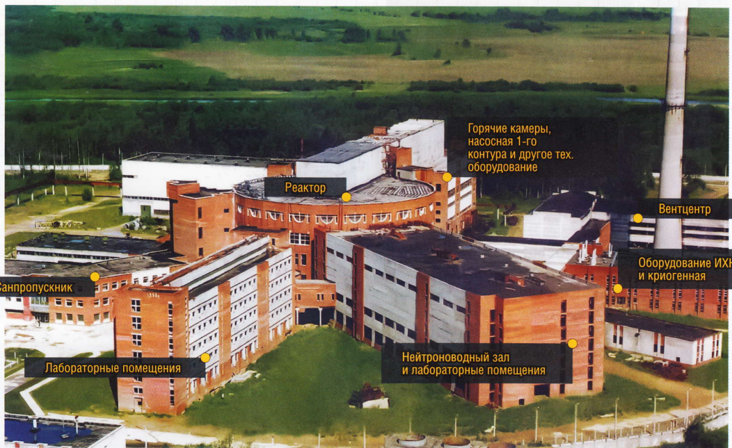
▲ Вид на реакторный комплекс
